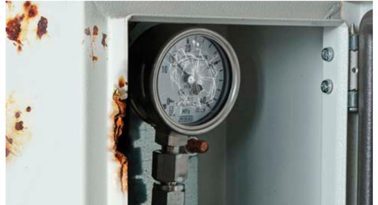
Fehlender Schutzkastenschlüssel, CNG-Stutzen oder Druckmesser beschädigt → Berechnung des Austauschs des gesamten Kastens.
