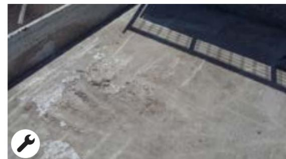
Spuren von Beton oder chemischen Produkten, die  $\geq$   $\frac{1}{4}$  der Oberfläche des Trichters bedecken
