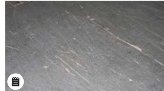
Bodenbelag: Leichte Verformung, oberflächlicher Verschleiß
