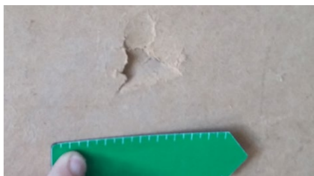
Innenraumverkleidung : Kleine Stoßspuren
